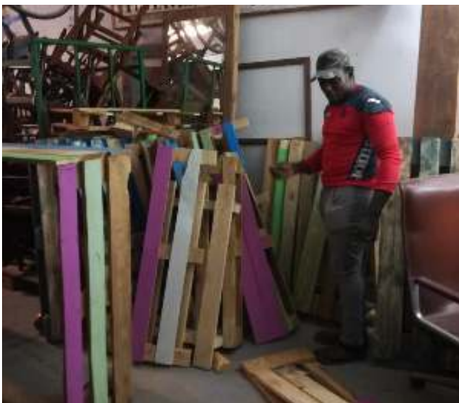
Trabajo en proceso, para instalación de “África Moment”
