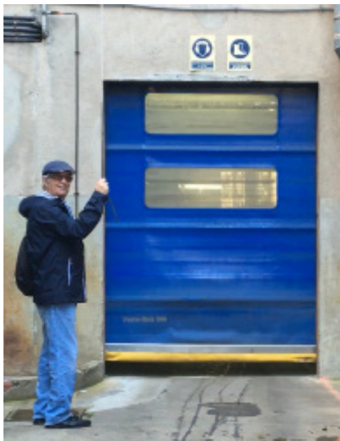
Porta que comunica les 2 parts de la fàbrica. Porta elèctrica però amb cable manual.
